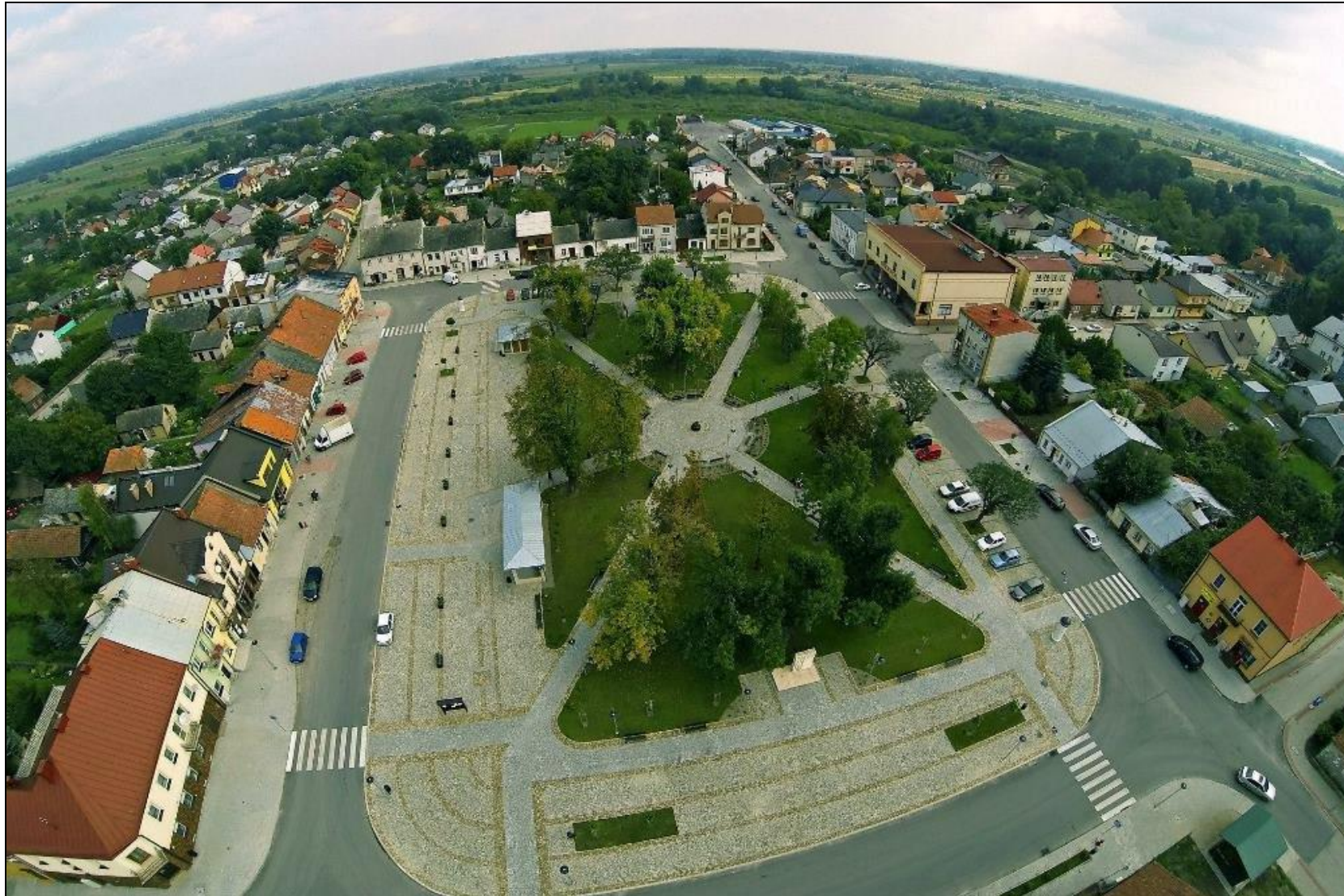
Zdjęcie 5 Rynek i park w Nowym Korczynie po zakończeniu I etapu rewitalizacji
