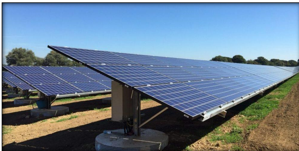
Zdjęcie 1 Przykładowa konstrukcja z zastosowaniem bloków żelbetowych
