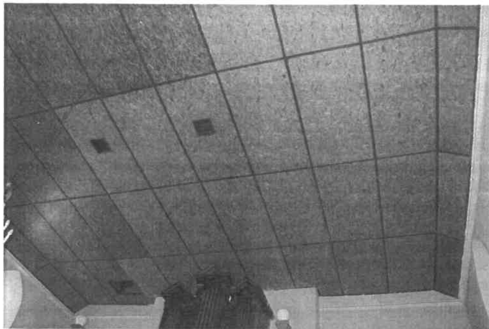
Fot.2. Piasek Wielki. Kościół p.w. św. Katarzyny Dz. i M.. Sufit w nawie wykonany z płyt drewnopodobnych. 2023 r.
