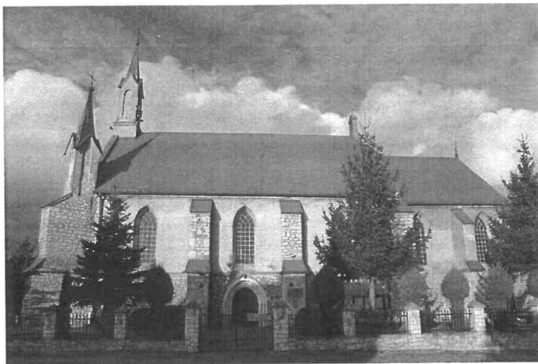
Fot. 2. Piasek Wielki. Kościół p.w. św. Katarzyny Dz. i M.. Widok z zewnątrz na kościół – elewacja południowa. 2023 r.
