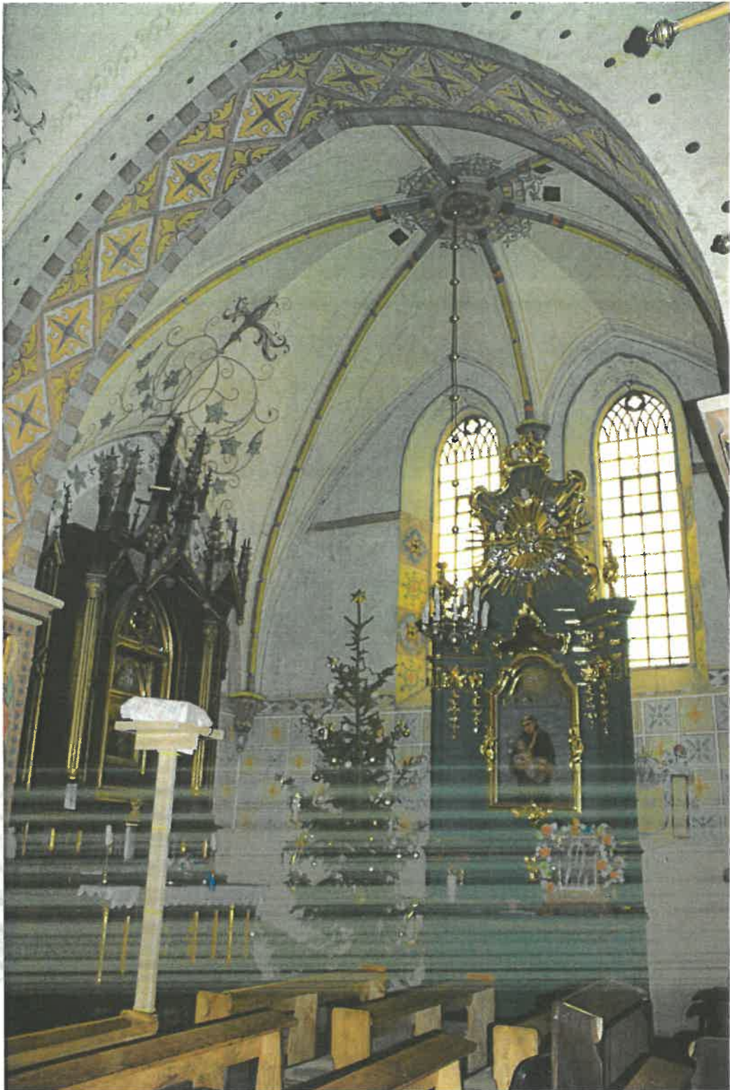
Fot. 8. Strożyska. Kościół p.w. Wniebowzięcia NMP. Kaplica boczna południowa. Widoczny obecny zły stan zachowania powierzchni polichromowanych. Widoczne przemalowania oryginalnej polichromii na ścianach i sklepieniu. 2023 r.
